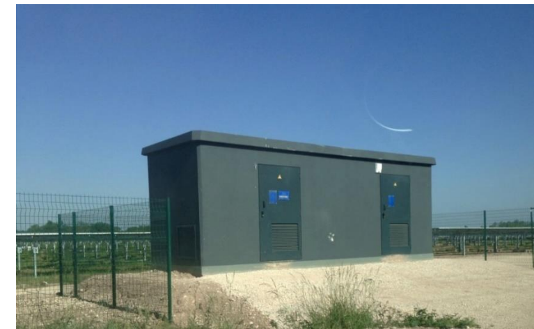
Figure 18 : Illustration d'un poste de livraison (source : URBASOLAR, 2017)
